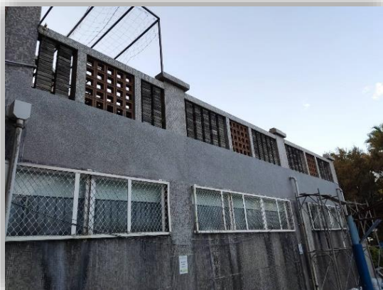
外牆抵石子工程
