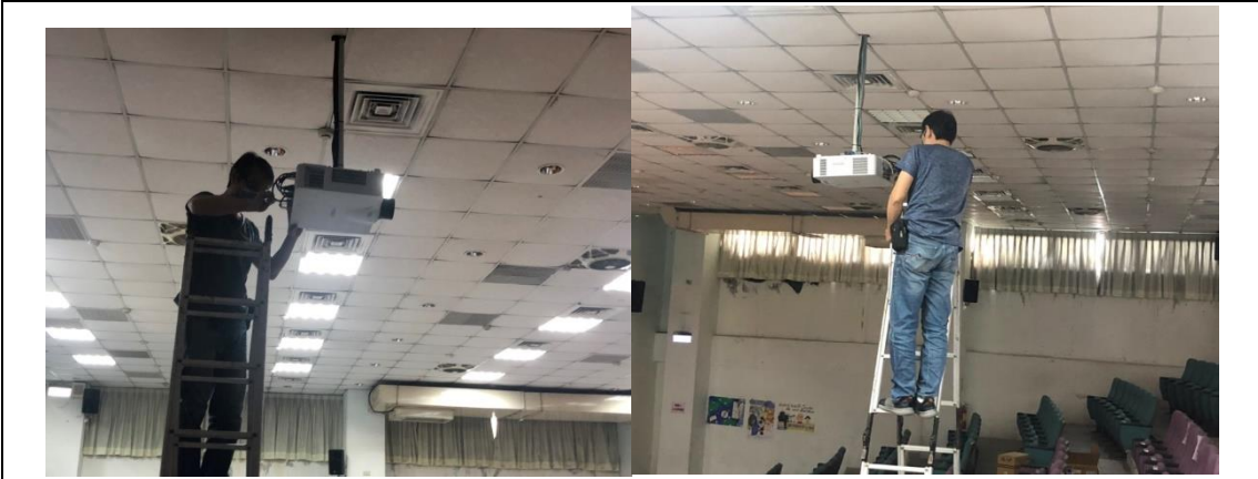
拆除舊有投影機器
