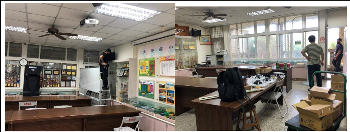
拆除舊有線路及備料
