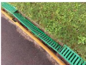
5水溝多處損壞
