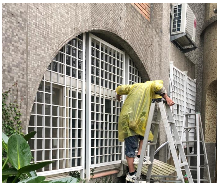
廚房外無遮陽設備，午後陽光直接照射廚房裡面
