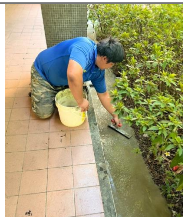
發現漏水由此處破洞而入
