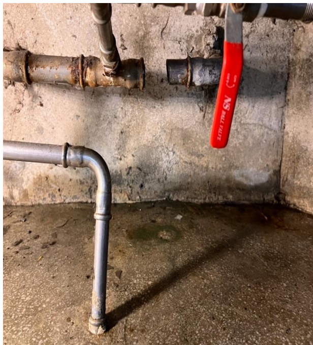
發現地下室涵管漏水需修繕止漏（施工前）
