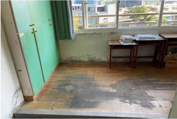
地板已磨損及塌陷需修繕更換（施工前）
