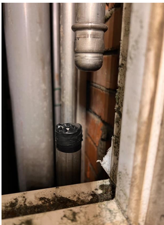
截斷水管止漏（施工中）
