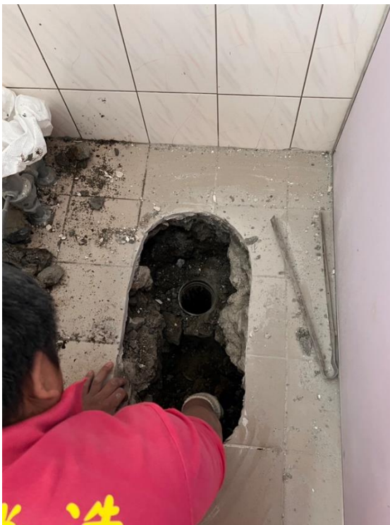
開挖捉漏（施工中）再行填補缺口（施工後）
