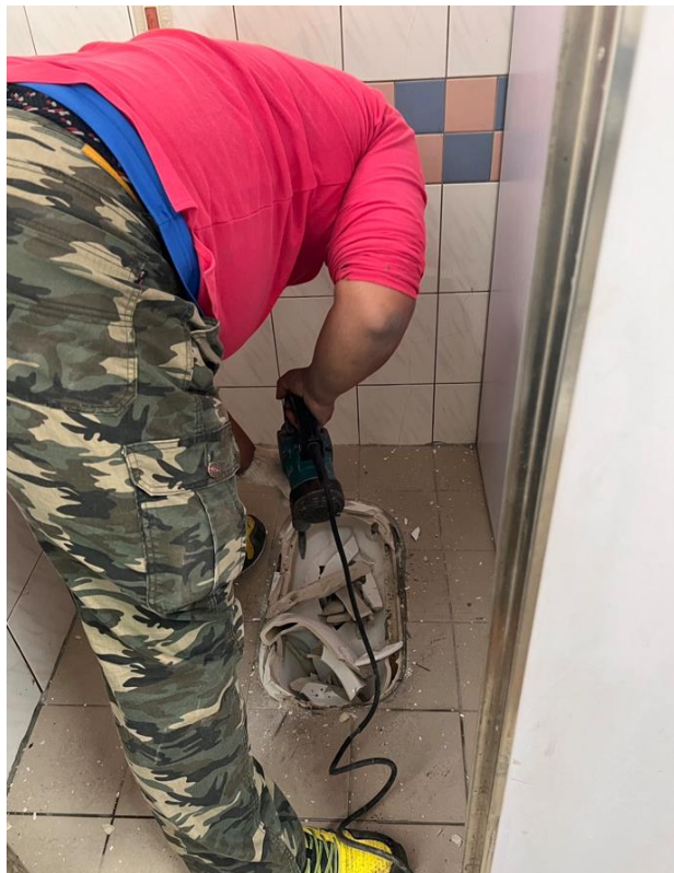
發現廁所漏水需進行修繕更換（施工前）
