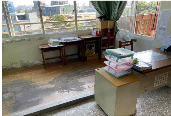
地板已磨損及塌陷需修繕更換（施工前）
