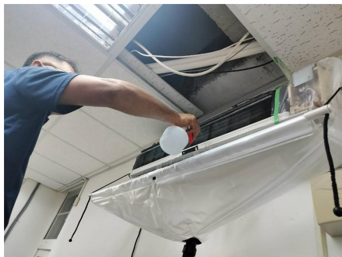
全校冷氣清洗中，包括班級冷氣、行政用冷氣計 100 組（內外機）
