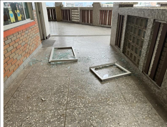
112.12.22 學生打掃時，關對面後門造成氣壓排擠，上方氣窗脫落
