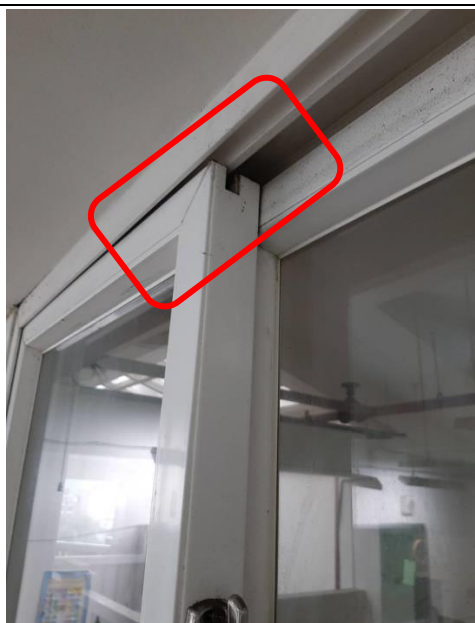
校長協同總務人員勘察，發現掉落原因及軌道脫離、變形狀況
